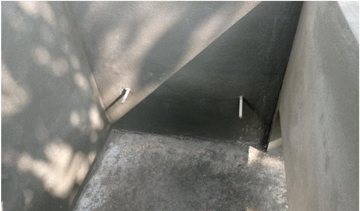
ပုံ (၁၀) - ဆီခံဖန်းကို ငါးကျပ်တိုက်စင်ထဲတွင် ထည့်သွင်းတပ်ဆင်နိုင်ရန် ကွန်ကရစ်လောင်းချိန်တွင် rebar သံချောင်းလေးခုကို ဘေးနံရံတွင် ထည့်သွင်းပေးခြင်း
