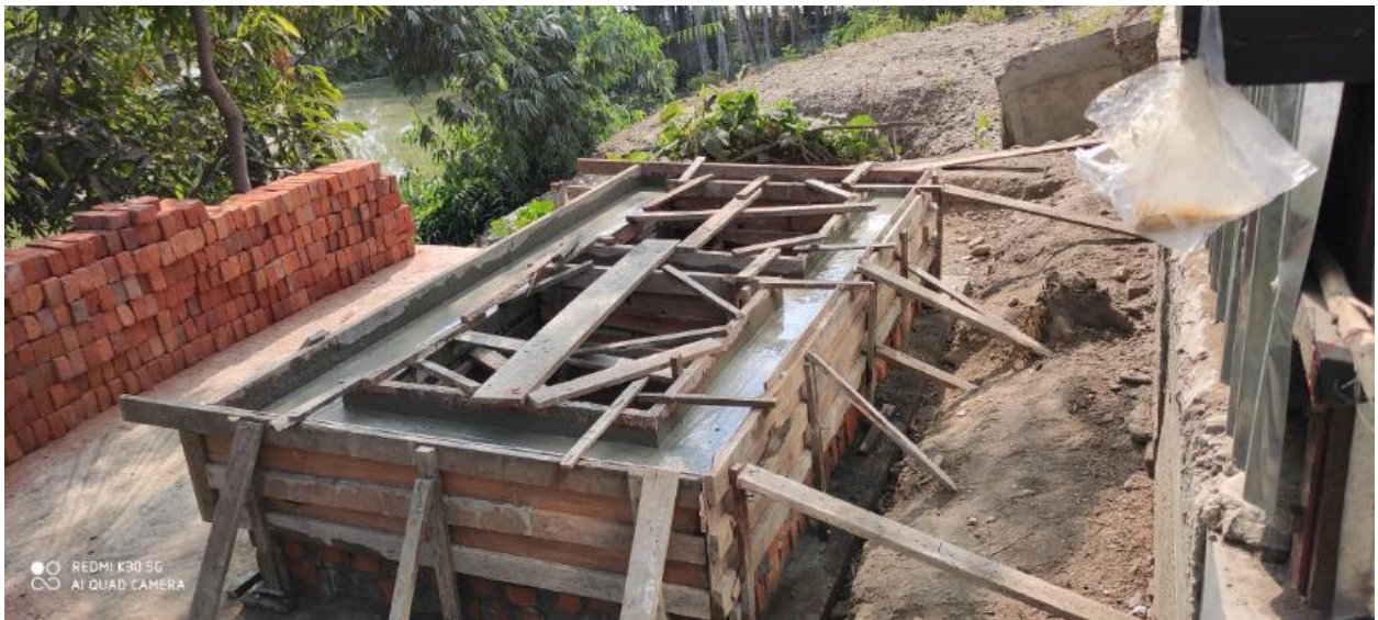
ပုံ (၆) - ဖျော်ထားသော ကွန်ကရစ်များအား လောင်းထည့်ရန် ပုံစံခွက်
