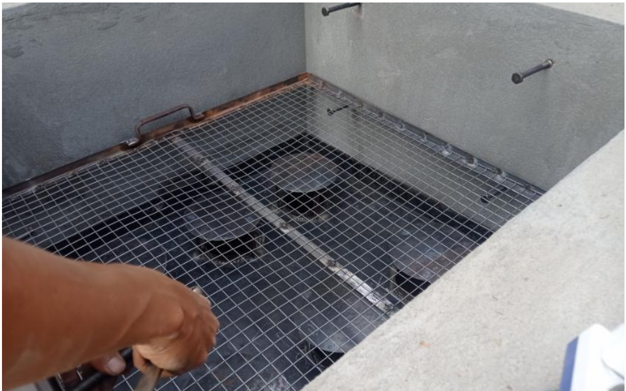
ပုံ (၁၂) - ကျပ်တိုက်စင်နံရံနှင့် ကျပ်ခိုးစင်တန်းများ/ဆီခဲဖန်းကြား နေရာလွတ် လုံလောက်စွာ ရှိ/မရှိ စစ်ဆေးခြင်း
