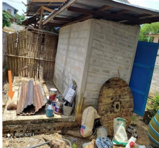
Photo 2. Pour flush toilet with a vent pipe.
